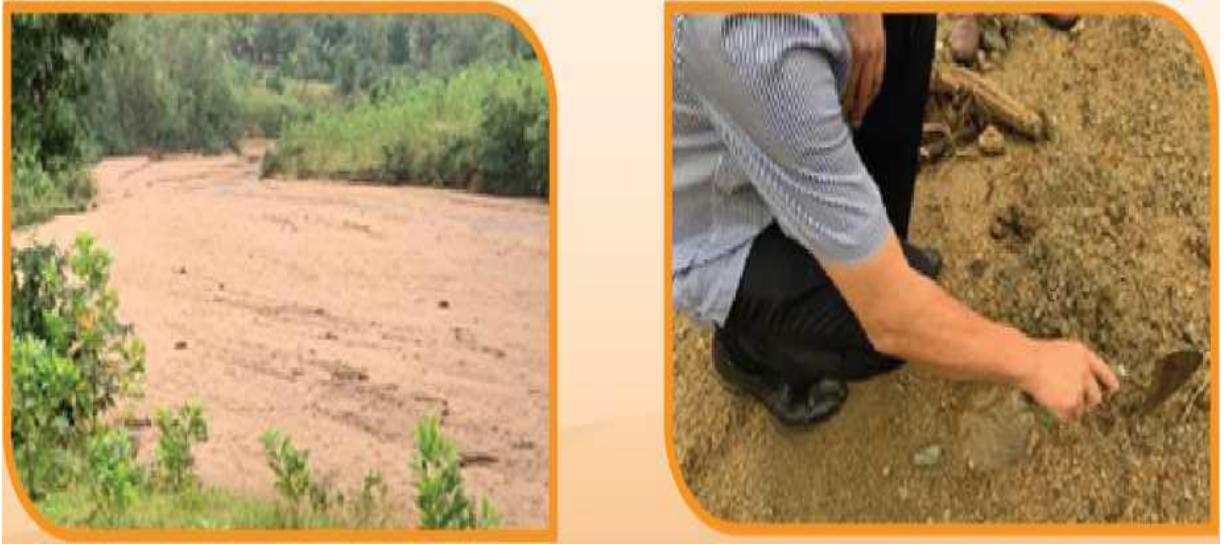
Khu đất bị lầy bởi lớp cát thô và sỏi sạn tại xã Kỳ Thượng, huyện Kỳ Anh, tỉnh Hà Tĩnh
